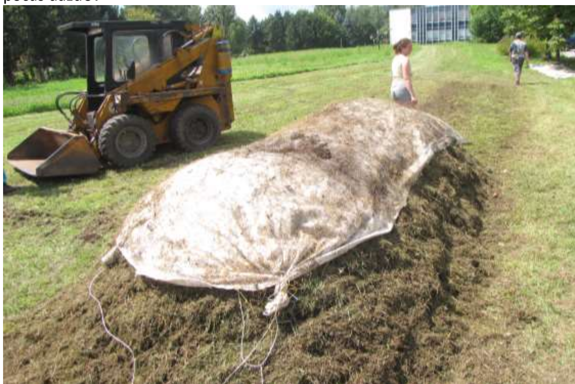
Obr. 5 Kompostovacie hroble boli zakryté geotextíliou z dôvodu ochrany pred vymývaním počas dažďov
